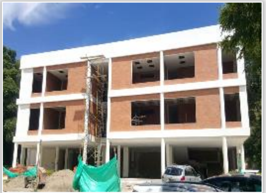
NUEVO EDIFICIO EN VILLA DEL ROSARIO
