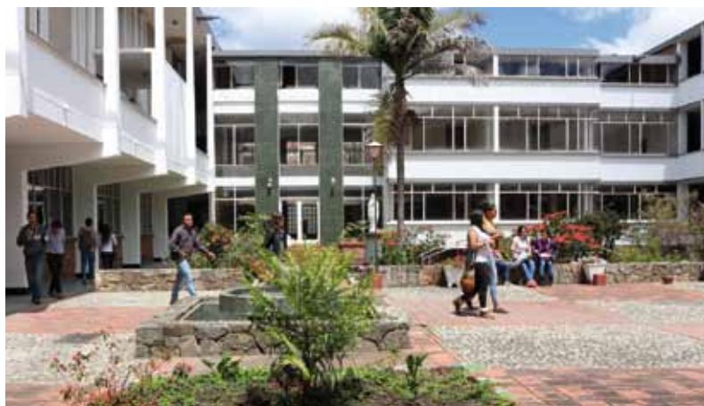
Construcción de comedores estudiantiles
