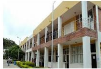
VULNERABILIDAD SISMICA DEL BLOQUE GRAMALOTE – VILLA DEL ROSARIO
