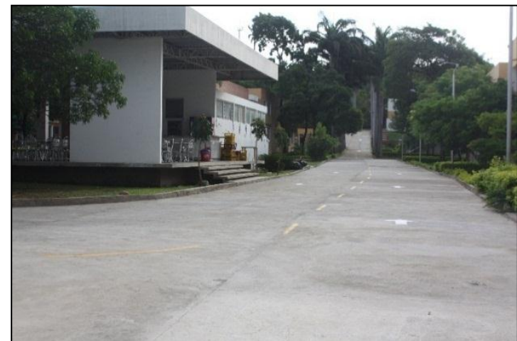
Pavimentación Villa del Rosario
