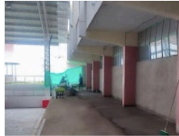
Instalación de gradería Metálica
