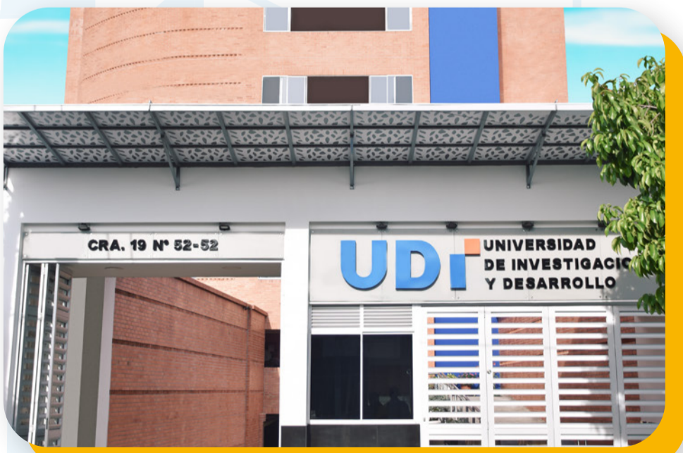
Edificio Marie Curie - Barrancabermeja
