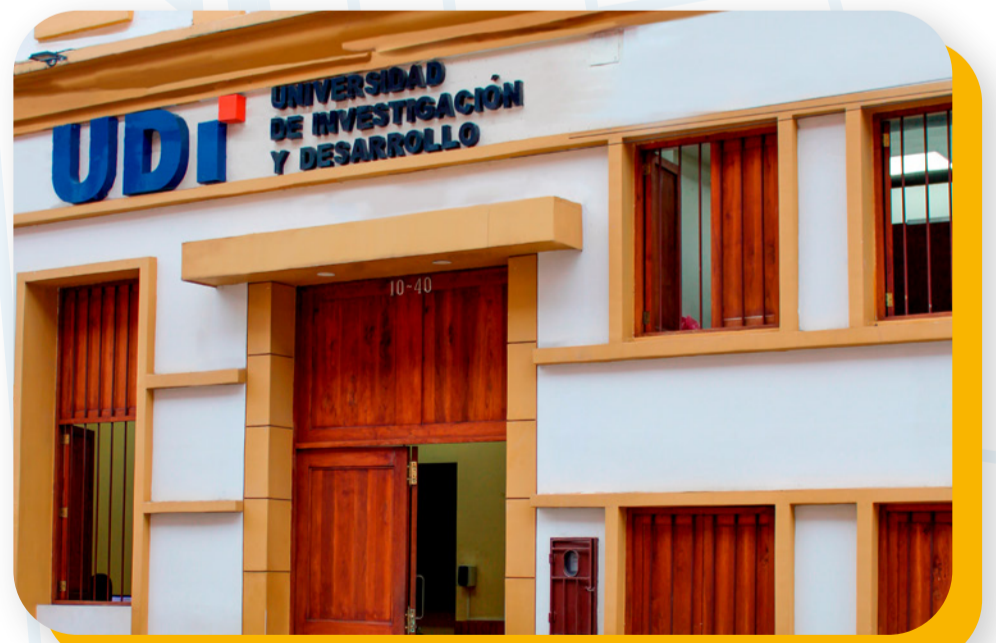
Edificio Leonhard Euler - San Gil
