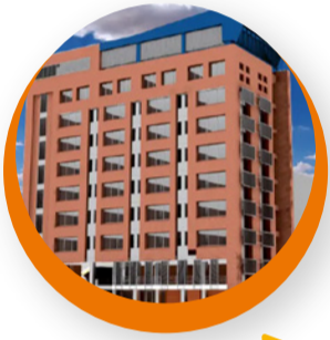
Edificio Ernesto Sábato
