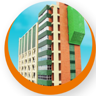
Edificio Daniel Bernoulli
