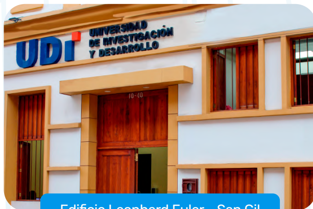
Edificio Leonhard Euler - San Gil
