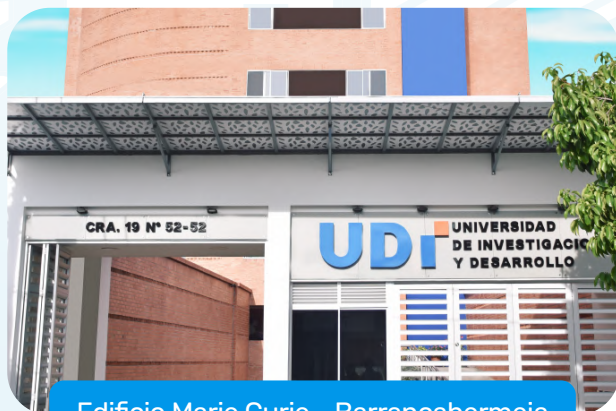
Edificio Marie Curie - Barrancabermeja
