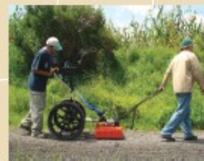
Radar de penetración terrestre (GPR)
