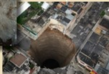
Zona de hundimientos
